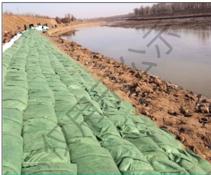
方案三：生态固袋护坡典型结构型式
